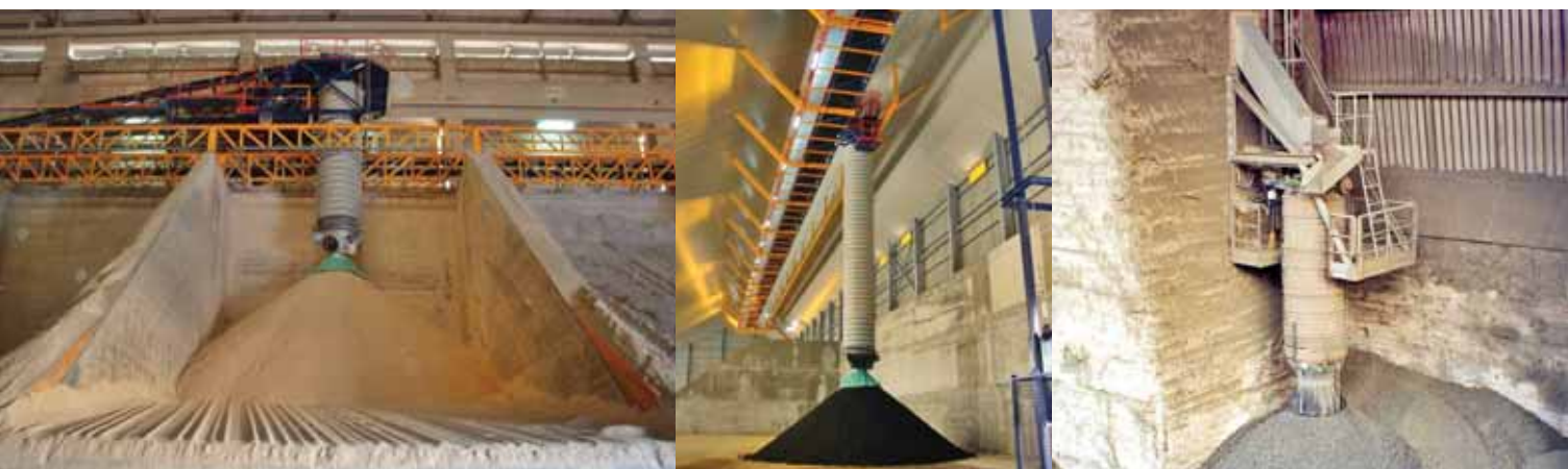
Ci-dessus - de gauche à droite : Chargement d'alumine, installations de stockage de gypse, stockage de charbon, stockage de scorie de ciment
